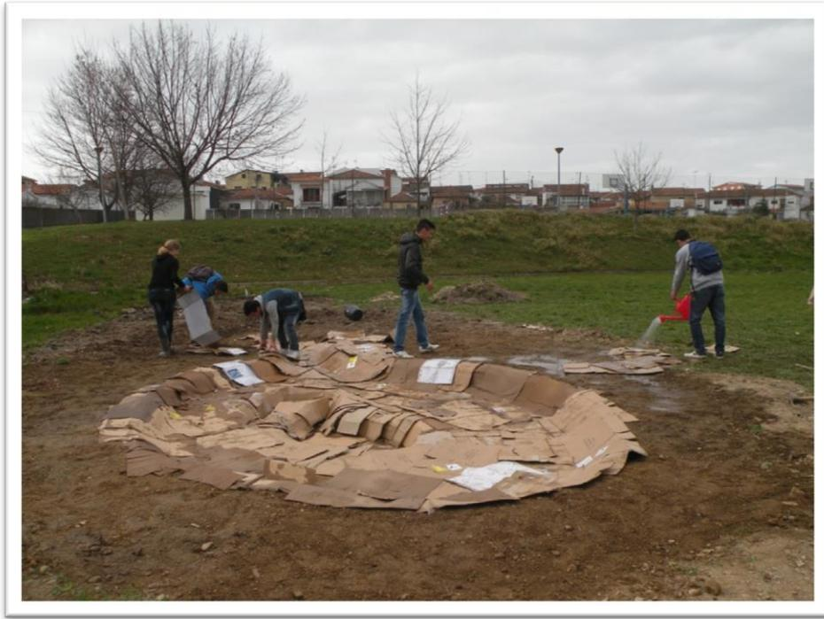
**Figura 6.** Revestimento com cartões para proteção da tela de impermeabilização.
